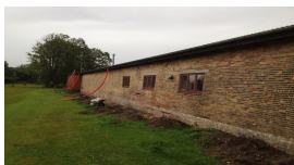
Facade før renovering
