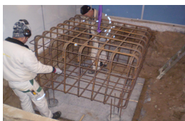
Montering af armeringskurv
